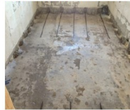
Slika05: Sidranje v opečne zidove
