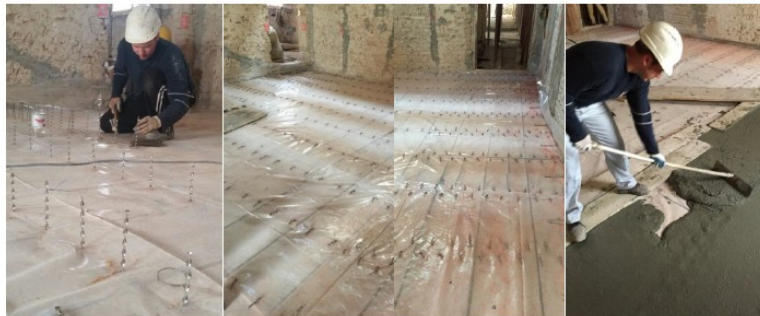
DETAJL B - monolitiziranje stropnikov in sidranje v opečne zidove - HPC.
