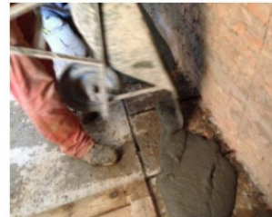
Slika05: Sidranje v opečne zidove
