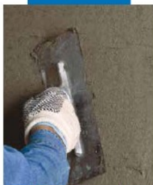
Nanos drugega, prekrivnega sloja malte Planitop HDM z gladilko čez mrežo Mapegrid G 220
